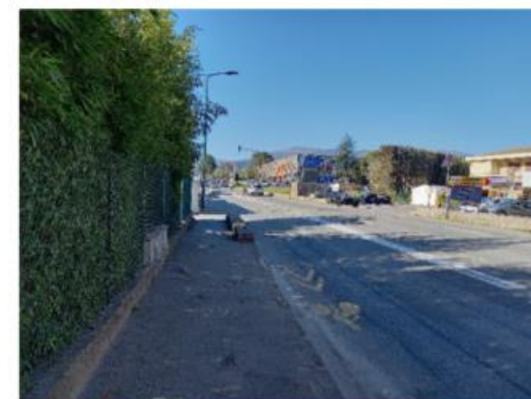
Bande cyclable temporaire et trottoir (Rte de Cannes)
