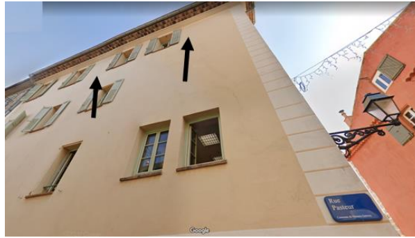
Figure 27. Emplacements possibles des gîtes façades sur la mairie annexe © Google street view, J.Costa – CEN PACA
