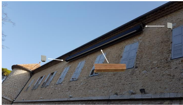
Figure 34. Positions possibles des gîtes à chiroptères sur le caisson de l'écran du vidéo projecteur © J. Costa – CEN PACA
