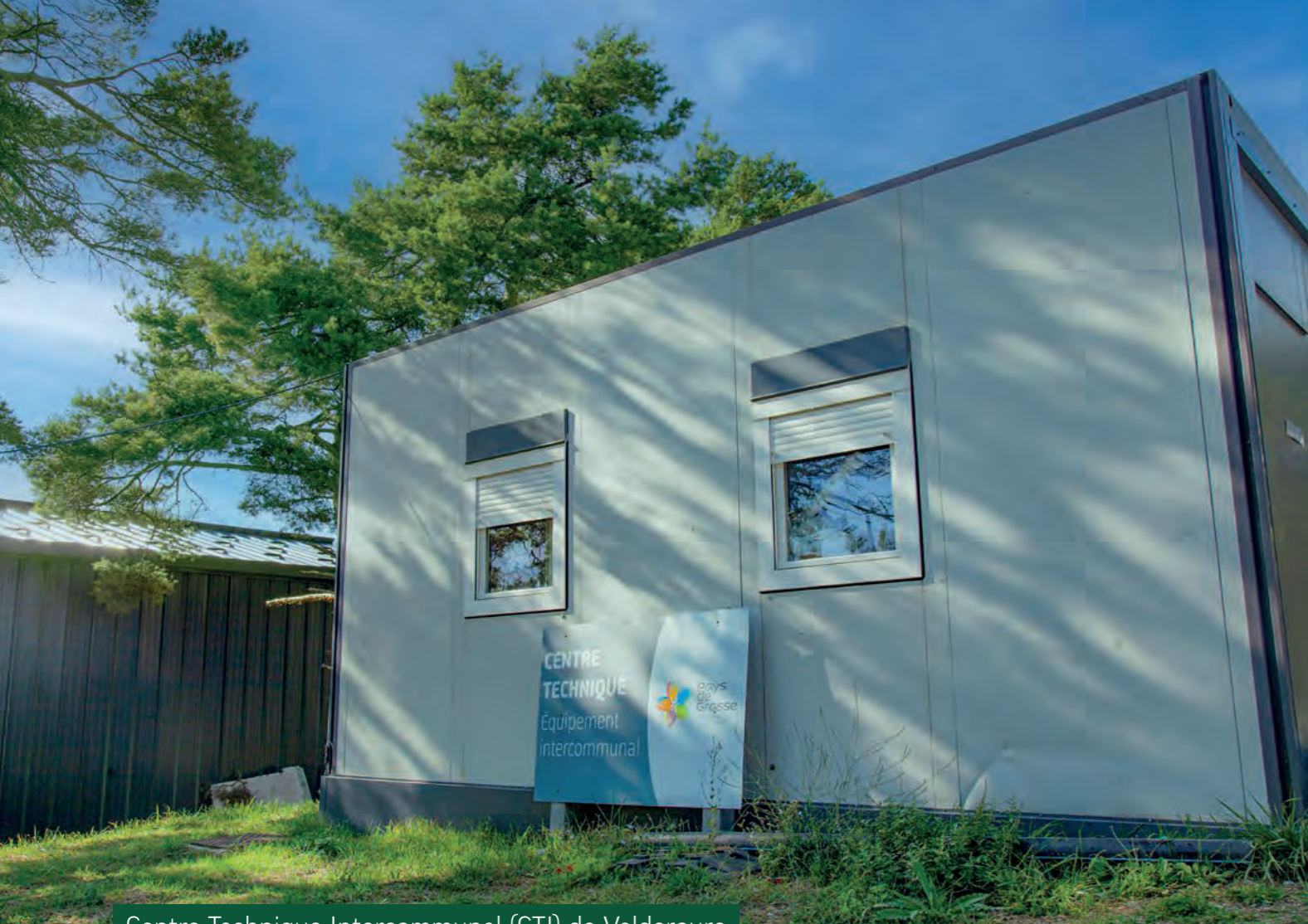
Centre Technique Intercommunal (CTI) de Valderoure
