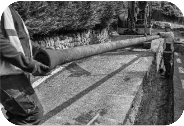
Renouvellement de 211 mètres de réseau AEP, chemin des Horts de la Salle à Mougins
