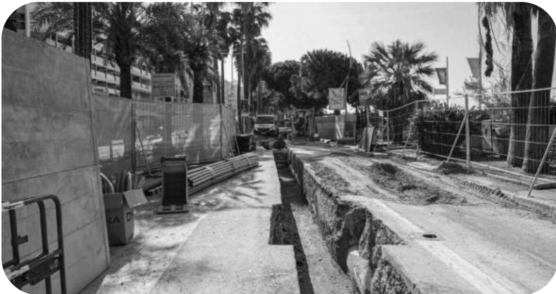
Restructuration du réseau AEP, 1 km en 150 mm, Croisette Sud à Cannes
