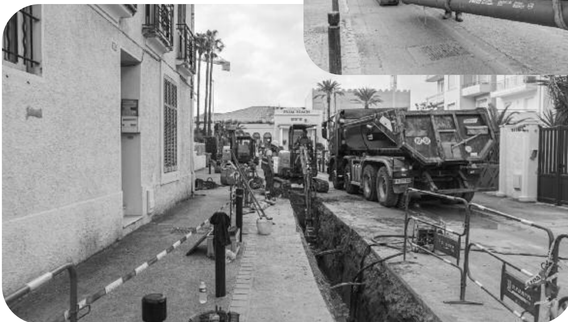
Renouvellement de 230 mètres du réseau AEP, avenue de Lérins à Cannes
