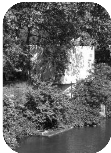
Prise d'eau de la Siagne
