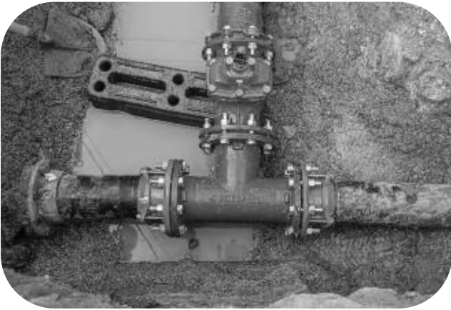
Renouvellement de 150 mètres réseau AEP pour défense incendie, avenue de la Gare du Funiculaire à Cannes
