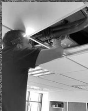
Pose d'une pompe économe en énergie à la station du Rousset
