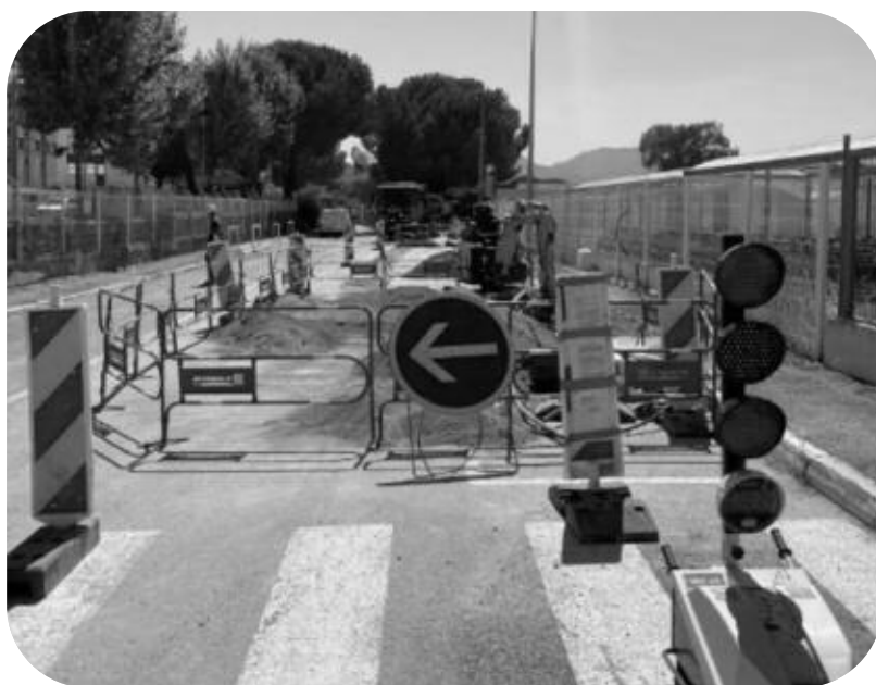
Renouvellement de 350 mètres du réseau AEP, allée des Gabians à Mandelieu
