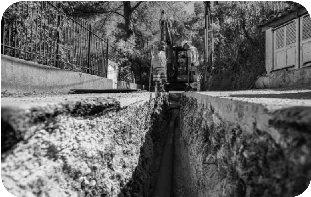
Renouvellement de 560 mètres de réseau AEP, chemin St. Barthélémy à Mougins
