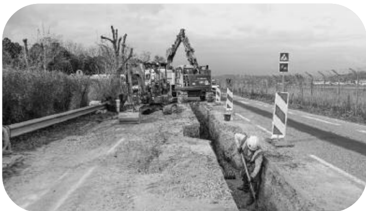
Renouvellement de 800 mètres de réseau AEP, avenue Gaston de Fontmichel à Mandelieu
