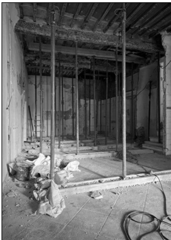
Photo de l'intérieur de l'îlot avec étaieiment (prise le 22 12 2022)
