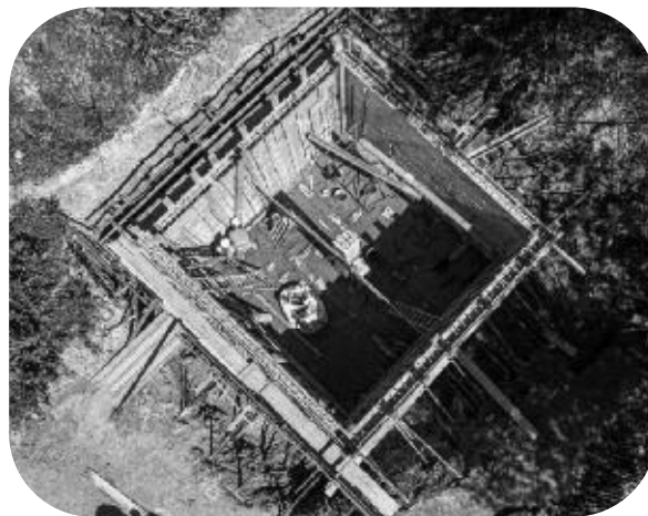
Création d'un réservoir incendie de 80 m 3 , chemin du Nid du Loup à La Roquette
