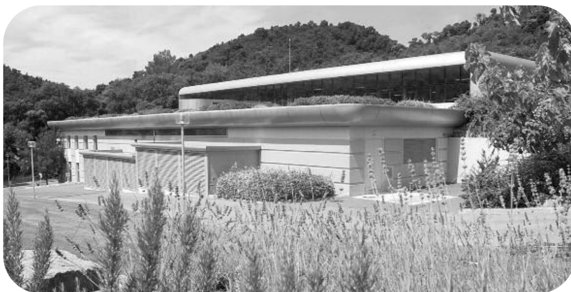
Apié - Usine d'ultrafiltration
