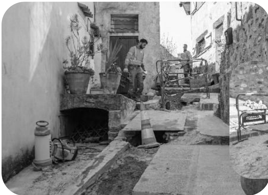
Renouvellement de 35 mètres de réseau AEP, rue du Four à Auribeau
