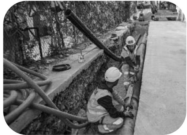
Renouvellement de 790 mètres de réseau AEP, chemin des Brusquets à Vallauris
