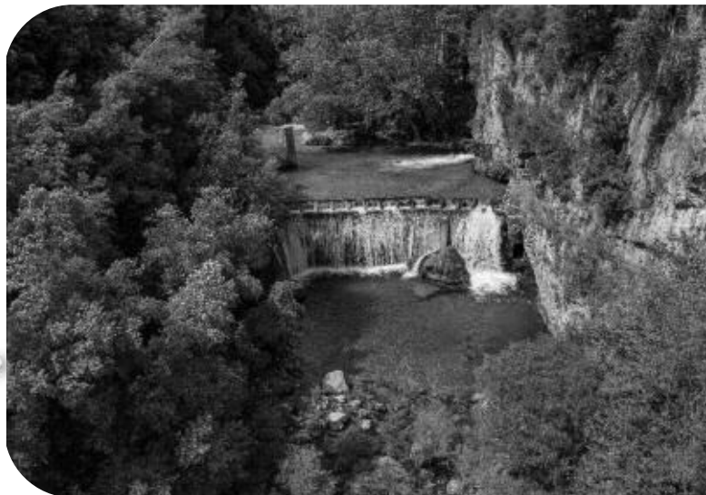
Barrage de Saint-Cézaire-sur-Siagne
