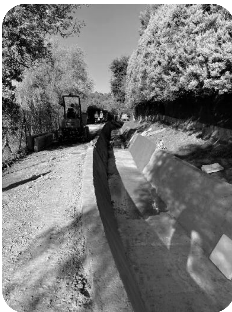
Renouvellement du canal de la Siagne Chemin de la Chapelle à Mougins
