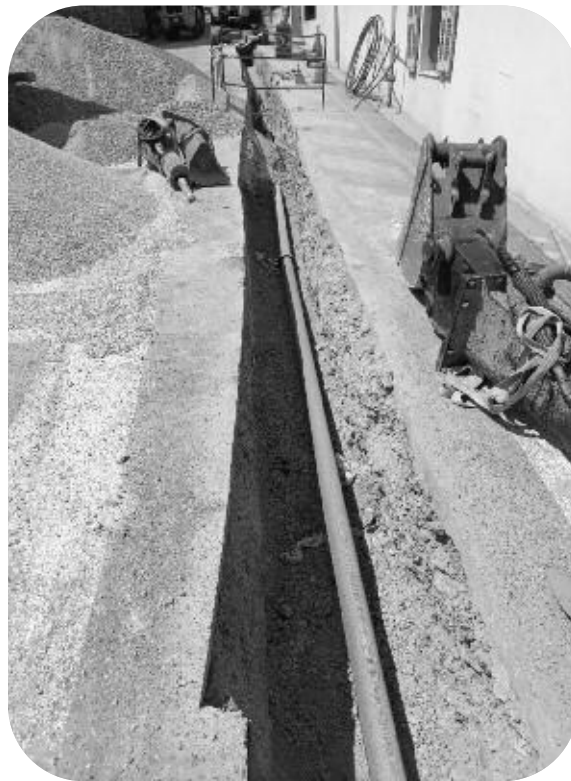
Renouvellement de 450 mètres de réseau AEP, rue de Lille, avenue du Petit Juas à Cannes
