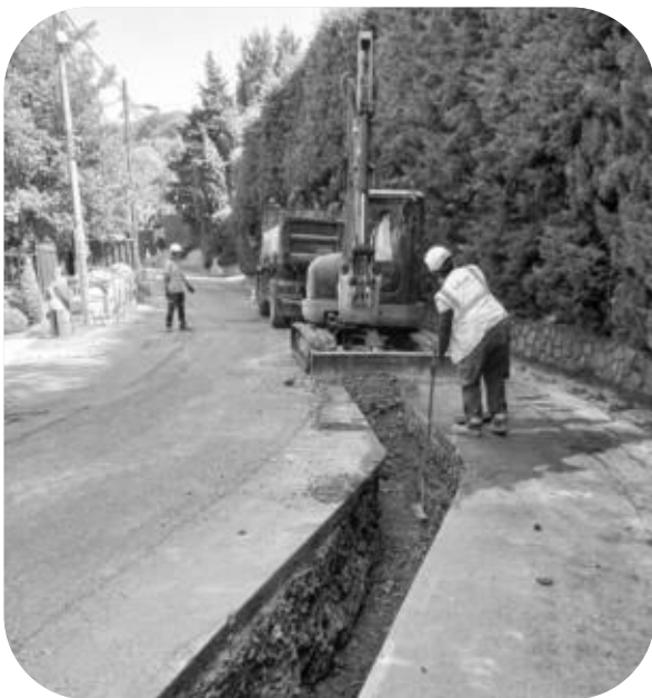
Renouvellement de 330 mètres de réseau AEP, chemin des Collines au Cannet
