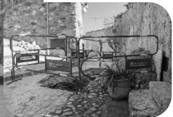
Renouvellement de 35 mètres de réseau AEP, rue du Four à Auribeau
