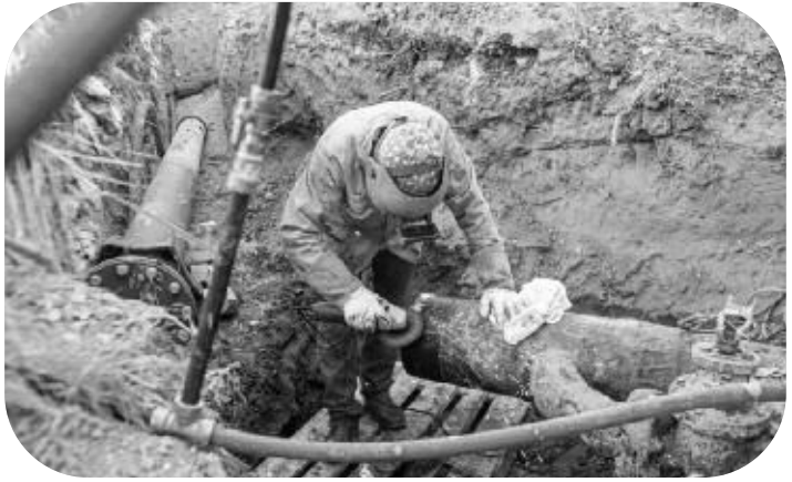
Réparation du réseau AEP, chemin des Grafouniers à Mandelieu
