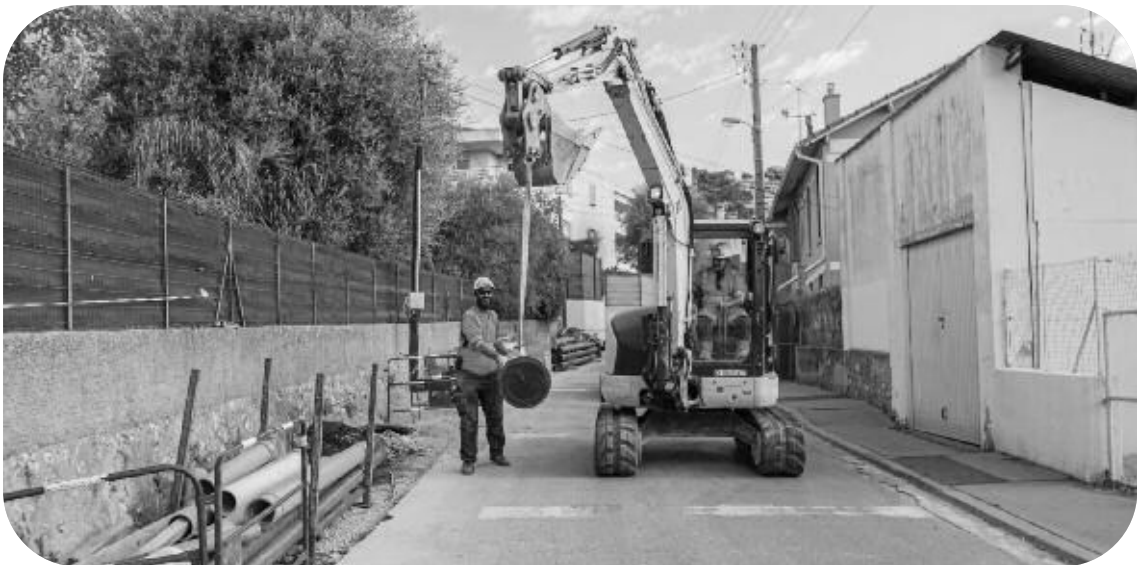
Renouvellement de 560 mètres de réseau AEP, rue de Cannes au Cannet
