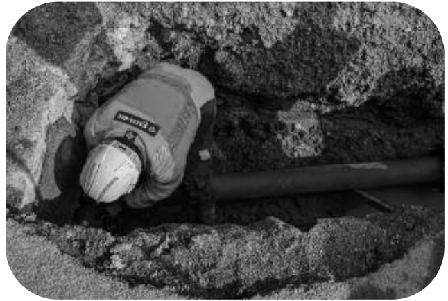
Renouvellement de 150 mètres réseau AEP pour défense incendie, avenue de la Gare du Funiculaire à Cannes
