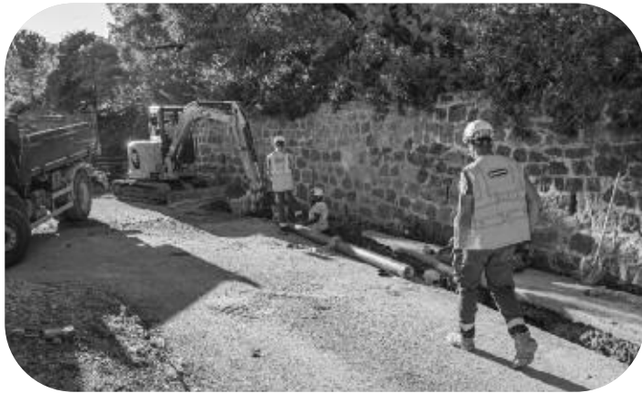
Renouvellement de 620 mètres de réseau AEP, chemin des Mimosées à Théoule
