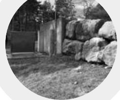
Réservoir la Faye (60 m³)
