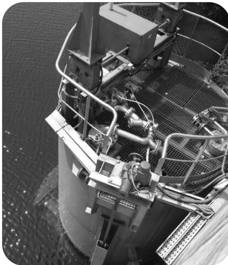
Prise du barrage de Tanneron sur la Siagne
