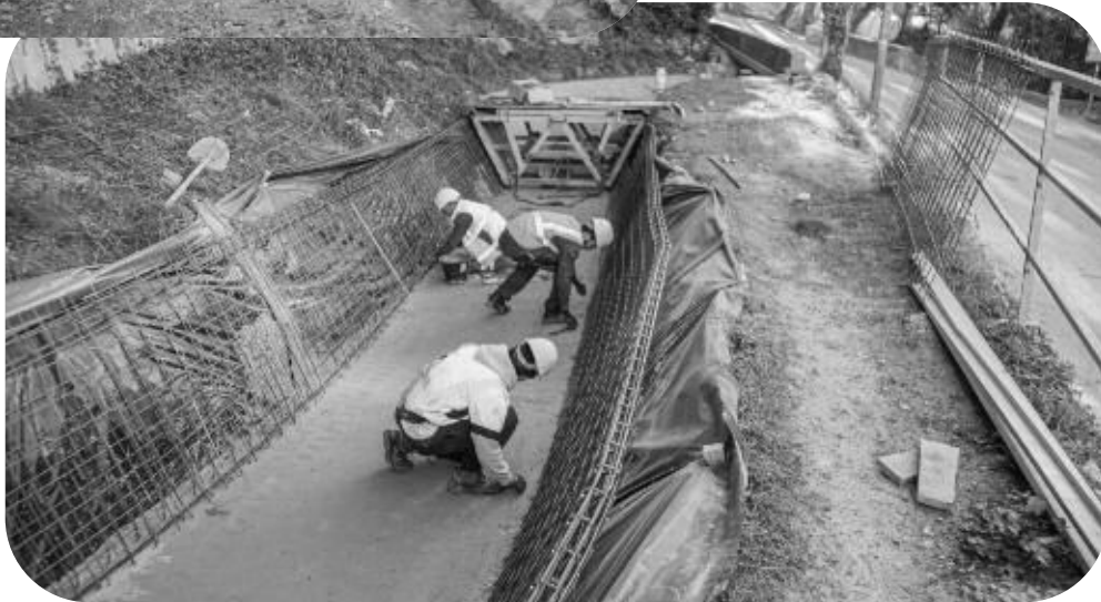
Travaux de renouvellement du canal de la Siagne, chemin de la Chapelle à Mougins
