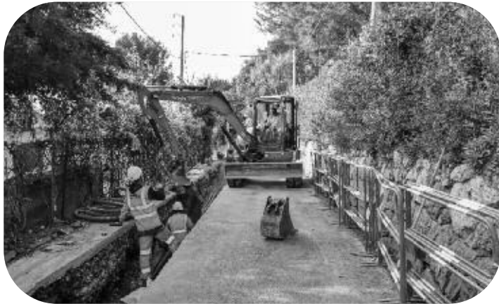
Renouvellement de 790 mètres de réseau AEP, chemin des Brusquets à Vallauris
