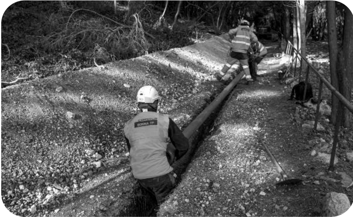
Travaux de renouvellement du réseau AEP Ile Ste Marguerite à Cannes
