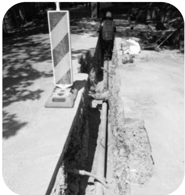
Renouvellement de 330 mètres de réseau AEP, chemin des Collines au Cannet
