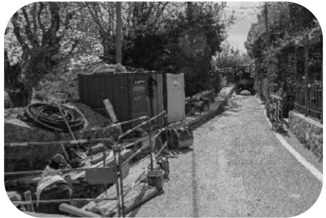
Renouvellement de 211 mètres de réseau AEP, chemin des Horts de la Salle à Mougins
