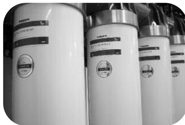
Mars 2017 - changement des membranes d'ultrafiltration
