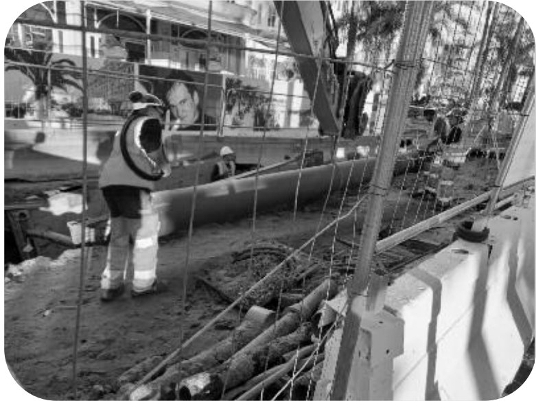
Restructuration de 1,3 km de réseau AEP en 400 mm de diamètre, Croisette chaussée nord à Cannes
