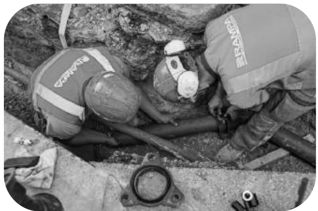
Renouvellement de 229 mètres de réseau AEP, chemin du Badier à Mougins
