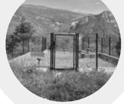
Réservoir la Serre (120 m³)
