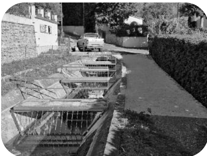
Mise en place d'un dégrilleur sur le Canal de la Siagne, chemin des Comtesses à Grasse
