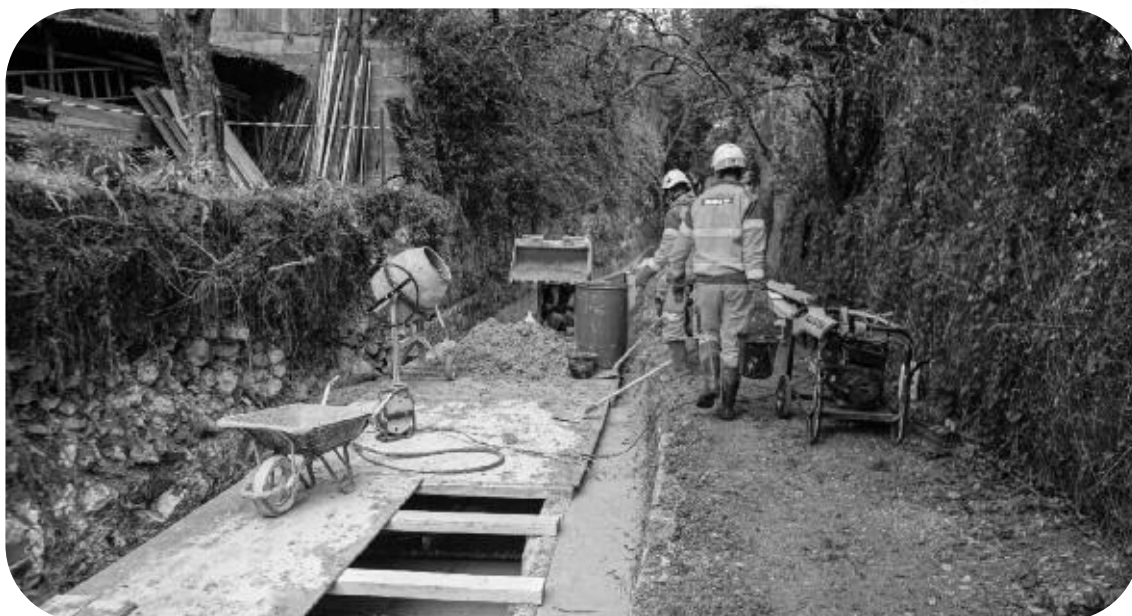
Réparation du mur écroulé sur 7 mètres au-dessus du canal à Grasse
