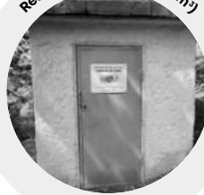
Réservoir de la Clue (35 m³)
