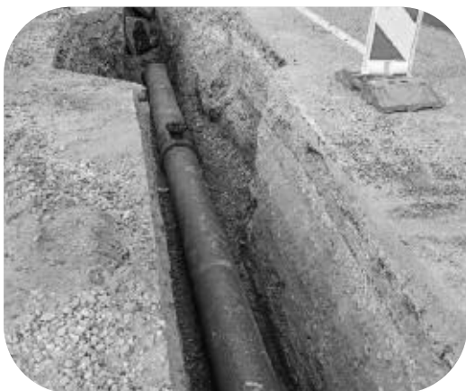
Renouvellement de 800 mètres de réseau AEP, avenue Gaston de Fontmichel à Mandelieu
