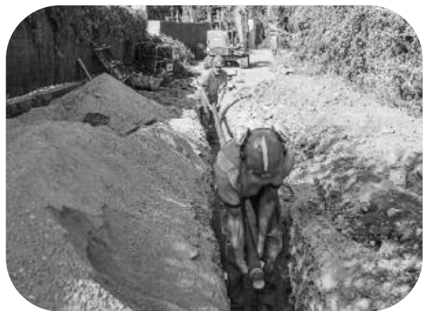
Renouvellement de 180 mètres de réseau AEP, ancien chemin de Mougins à Vallauris
