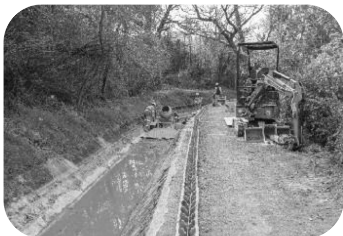
Réhausse de la berge du canal de la Siagne et création d'une surverse à Grasse St Mathieu
