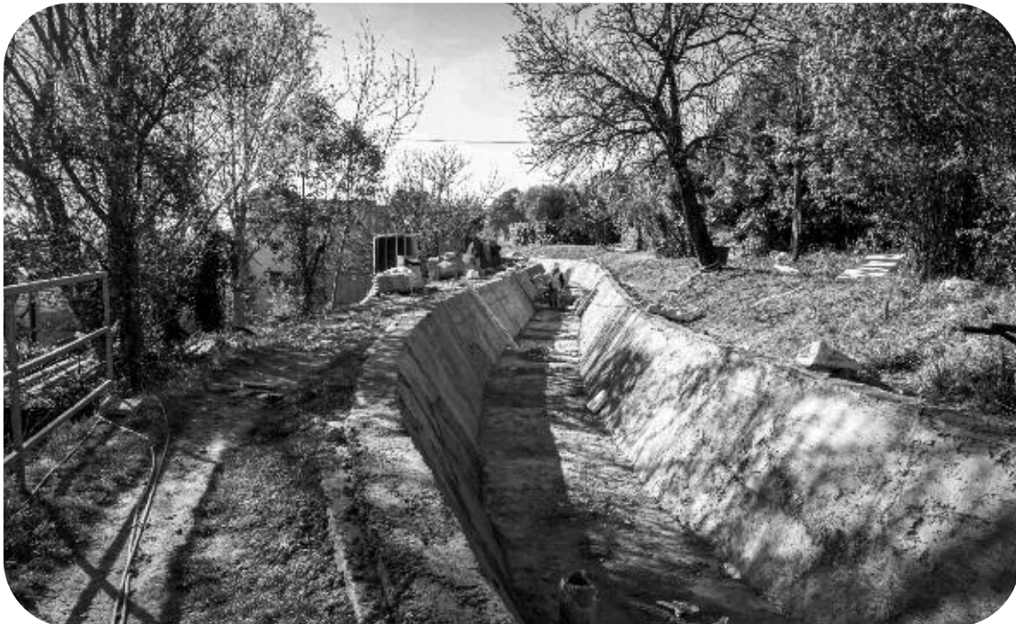
Renouvellement du canal de la Siagne à Peymeinade
