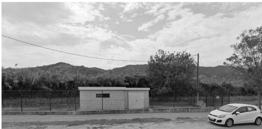
Poste de relèvement de Bastidon
