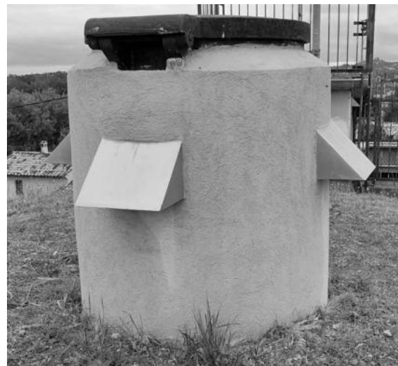
Roure de la Gâche : 6 ventilations ont été remplacées
