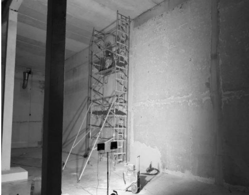
Réalisation de la mise à nu des parois du réservoir
