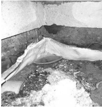
Photos avant et après d'une partie du défaut d'étanchéité de la toiture
