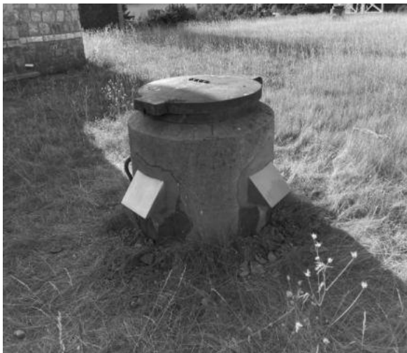
3 Portes : 8 ventilations ont été remplacées
