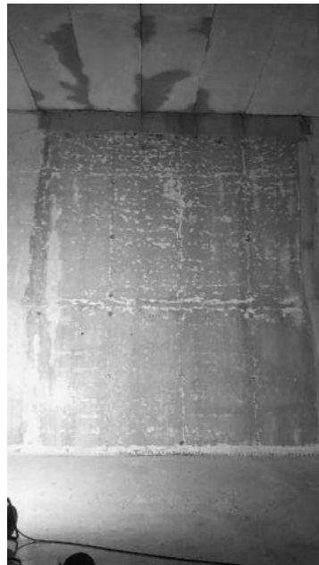
Photos d'une partie des infiltrations d'eau entraînant l'arrêt du chantier
