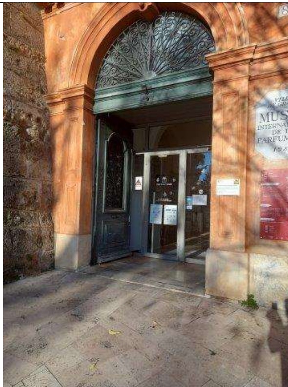
Mise en conformité du seuil de l'entrée de la boutique du MIP (ressaut)
