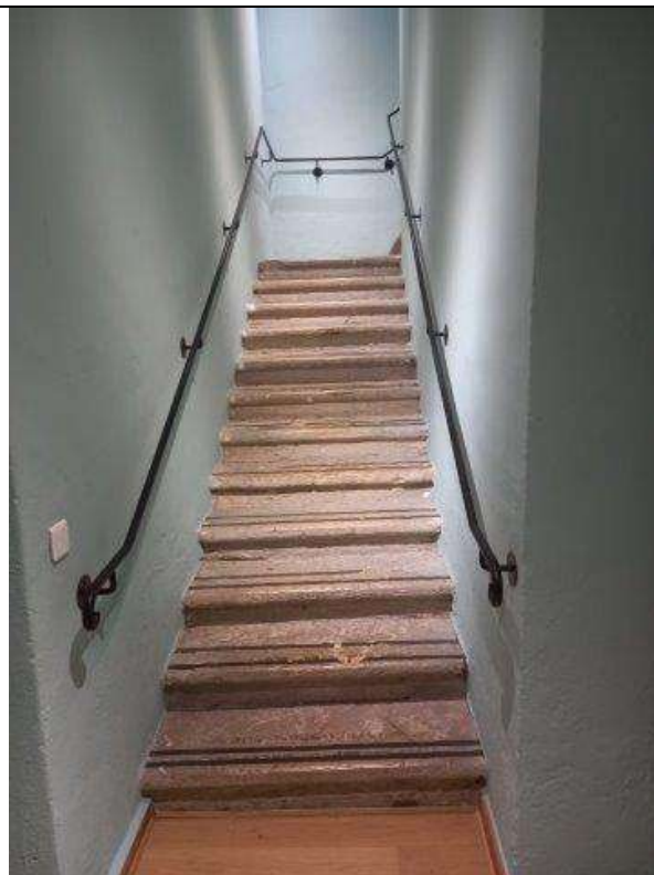
Mise en conformité d'escalier avec continuité et prolongation de main courante
