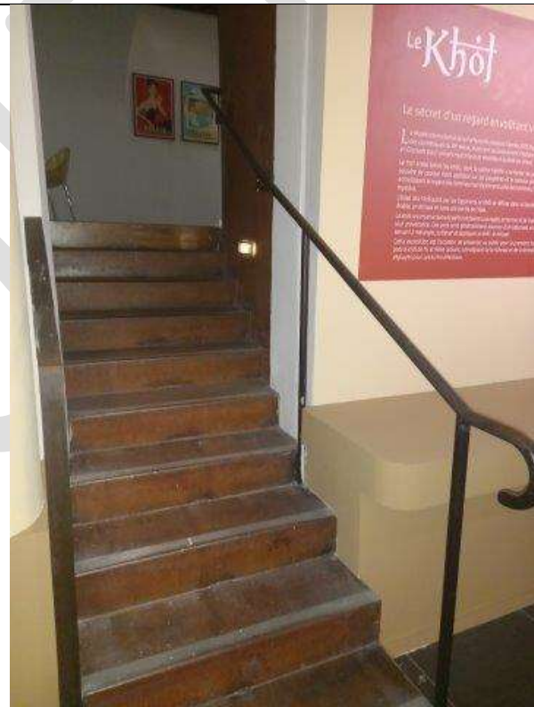
Mise en conformité d'escalier avec prolongation de main courante
