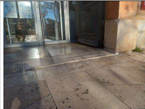
Mise en conformité du seuil de l'entrée de la boutique du MIP (ressaut)
