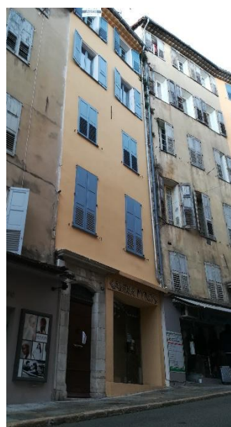
Façade 3 rue Amiral de Grasse
