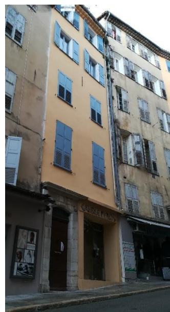
Façade 3 rue Amiral de Grasse
