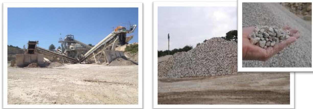
Figure 34 Valorisation de bétons issus de déconstruction
