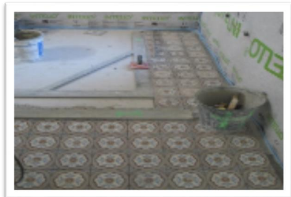
Figure 33 Dépose et repose de carreaux ciment de carrelage lors de la réhabilitation d'un bâtiment
