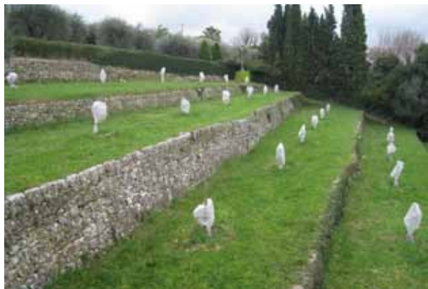
Des murs hauts et des terrasses étroites pour aménager une pente forte, Plascassier - Grasse. Marie Gautier, CRPF.
