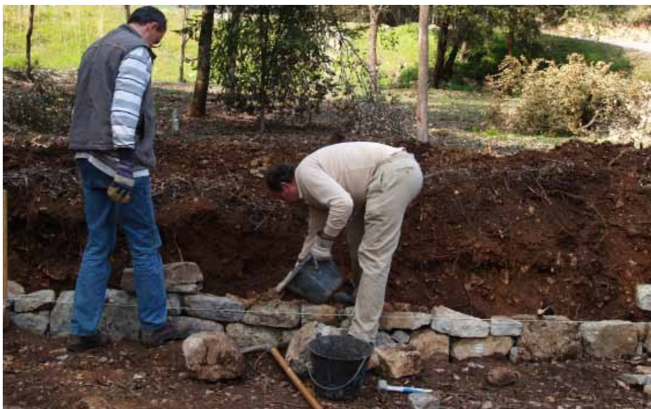
Construction d'un mur en pierres sèches, Auribeau-sur-Siagne, CAPAP.
