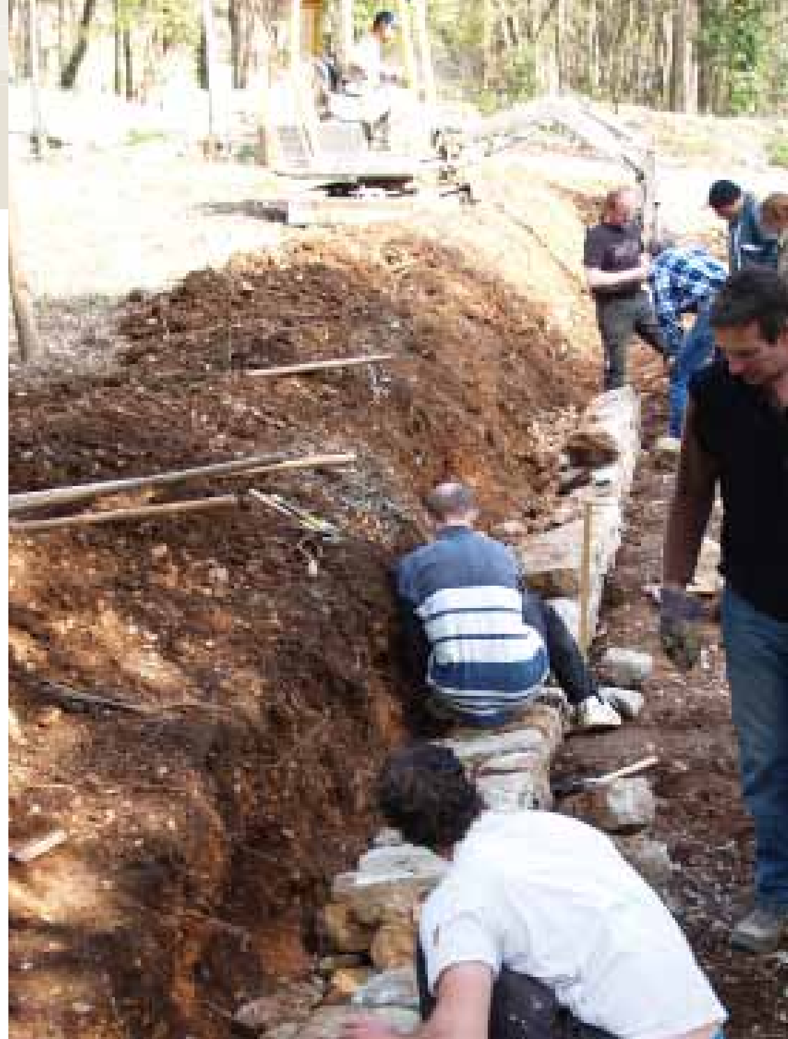
Construction d'un mur en pierres sèches, Auribeau-sur-Siagne, CAPAP.
