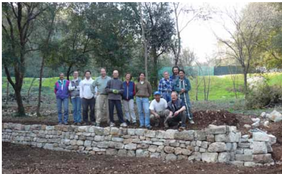
Chantier d'initiation à la pierre sèche, Auribeau-sur-Siagne, mars 2012. Jean-Michel André, Apare.
