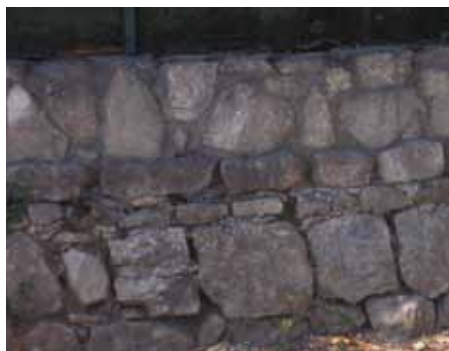
Le bas du mur est conforme à l'esthétique des murs en pierres sèches tandis que sur le haut les joints en ciment sont trop visibles, CAPAP.
