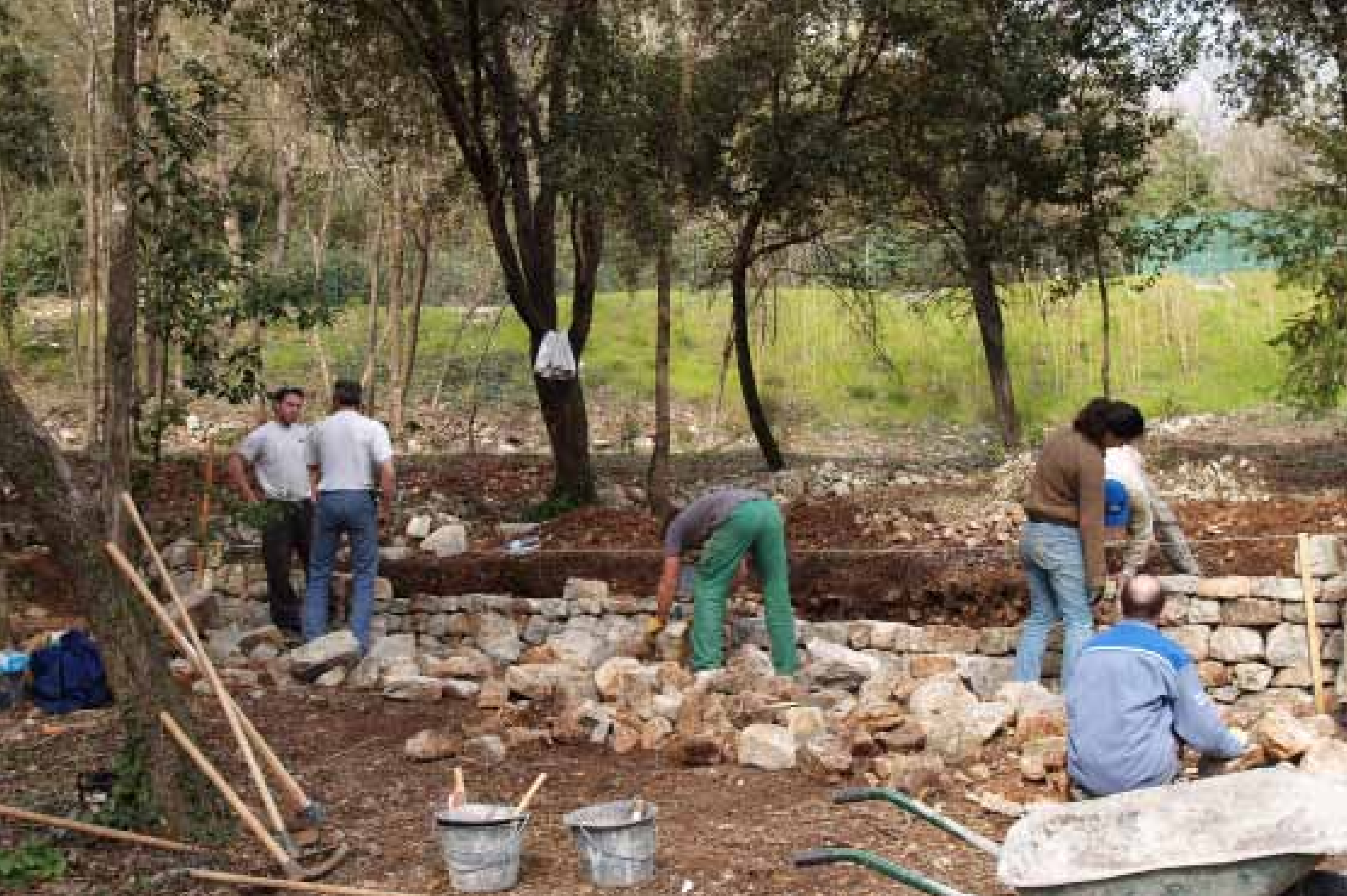
Construction d'un mur en pierres sèches, Auribeau-sur-Siagne, CAPAP.
